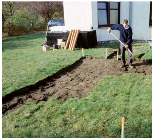
Abb. links: Abstecken der Baugrube.
